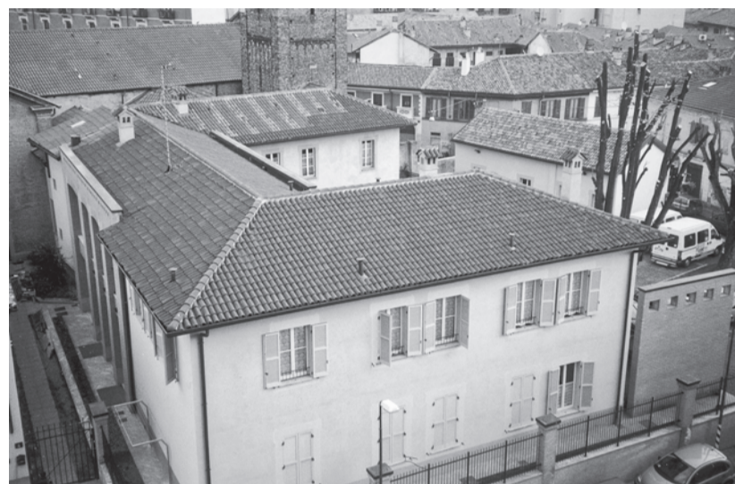
Via Sgambati - La Comunità Alloggio.
